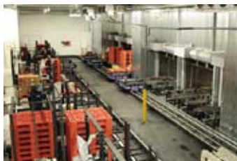
冷凍パレット自動倉庫
